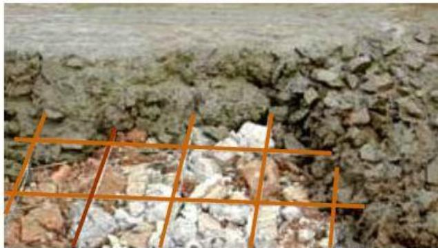
La charge (poids) reposant sur une dalle ou un linteau exerce une **compression** sur la partie supérieure du béton, créant une **tension** sur la partie inférieure. En plaçant l'armature au bas du béton, cette tension est supprimée.
