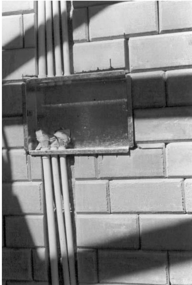
D'autres conduits, comme ceux dédiés à la plomberie et aux égouts, peuvent également être exposés. Toutes les conduites doivent être recouvertes d'une peinture imperméable et leurs joints doivent être parfaitement étanches afin d'éviter que les blocs ne soient endommagés en cas de fuites d'eau associées aux conduites.
